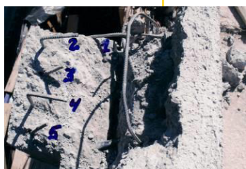
Vistas da Marquise Sinistrada Armaduras e Ancoragem
