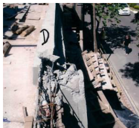
Vistas da Marquise Sinistrada Armaduras e Ancoragem
