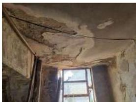
**FIGURA 21** - Infiltração generalizada nos apartamentos abaixo do terraço | Fonte: Dados produzidos pelo autor (2021)
