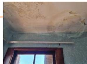
**FIGURA 23** - Desgaste da pintura interna | Fonte: Dados produzidos pelo autor (2021)
