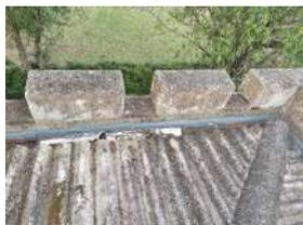
**FIGURA 7** - Calha com manta asfáltica | Fonte: Dados produzidos pelo autor (2021)
