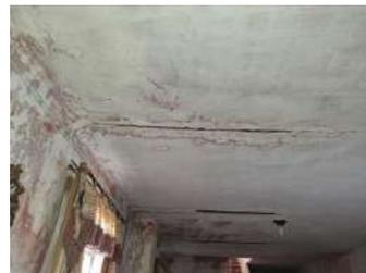
**FIGURA 9** - Infiltração no Castelo pela laje superior (terraço) | Fonte: Dados produzidos pelo autor (2021)
