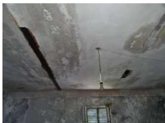
**FIGURA 10** - Laje com infiltração, trilho enferrujado | Fonte: Dados produzidos pelo autor (2021)
