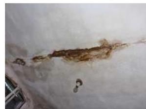
**FIGURA 12** - Oxidação da estrutura (lajes superiores) | Fonte: Dados produzidos pelo autor (2021)
