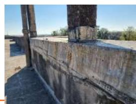
**FIGURA 20** - Manta asfáltica desgastada na platibanda | Fonte: Dados produzidos pelo autor (2021)
