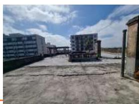
**FIGURA 19** - Reformas parciais deixaram o piso desnivelado | Fonte: Dados produzidos pelo autor (2021)
