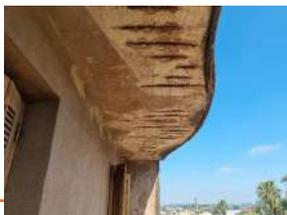
**FIGURA 24** - Oxidação e deslocamento das armaduras nas lajes em balanço | Fonte: Dados produzidos pelo autor (2021)
