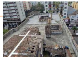
**FIGURA 15** - Terraço do edifício sem manutenção. | Fonte: Dados produzidos pelo autor (2021)
