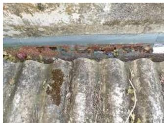
**FIGURA 8** - Calha sem manutenção | Fonte: Dados produzidos pelo autor (2021)
