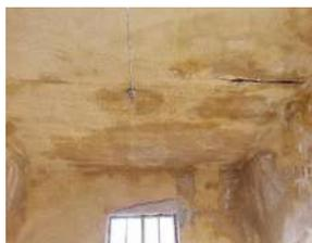
**FIGURA 11** - Infiltração no Castelo por toda laje de cobertura | Fonte: Dados produzidos pelo autor (2021)
