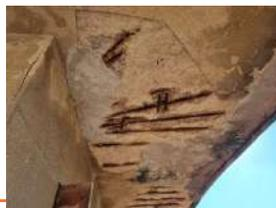
**FIGURA 25** - Correção inadequada, continuação de oxidação e deslocamento | Fonte: Dados produzidos pelo autor (2021)
